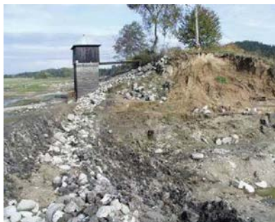
Fig. 7 Metelský rybník (2002), failure by overtopping [photo: Říha]
